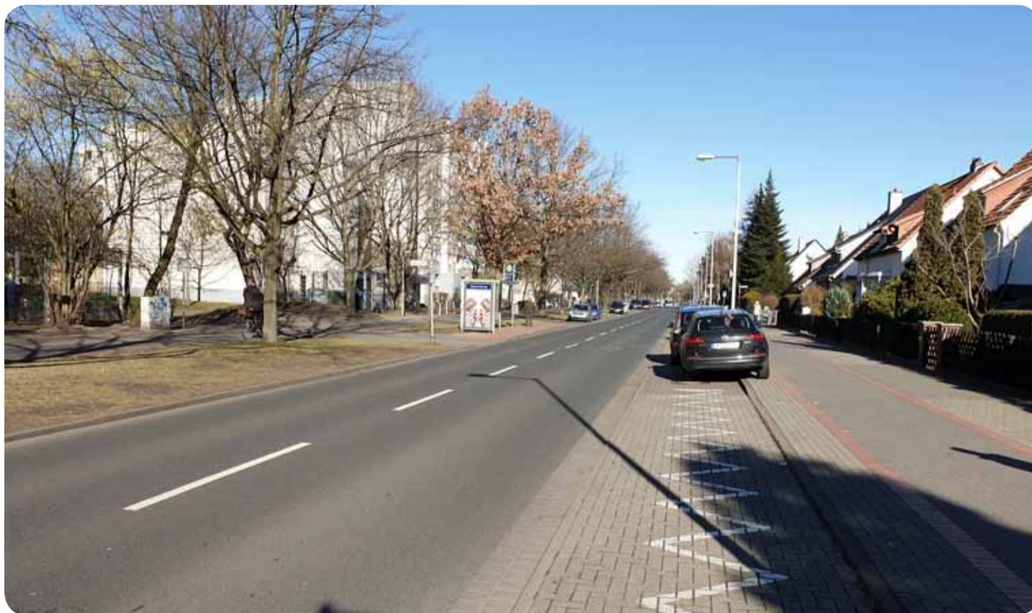
Die General-Wever-Straße kann dank einer Mittelinsel auf der Fahrbahn künftig sicherer überquert werden.
